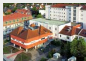
Krankenhaus Rahden Hohe Mühle 3 32369 Rahden Telefon: 05771 / 708 - 0
