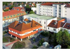
Krankenhaus Rahden Hohe Mühle 3 32369 Rahden Telefon: 05771 / 708 - 0
