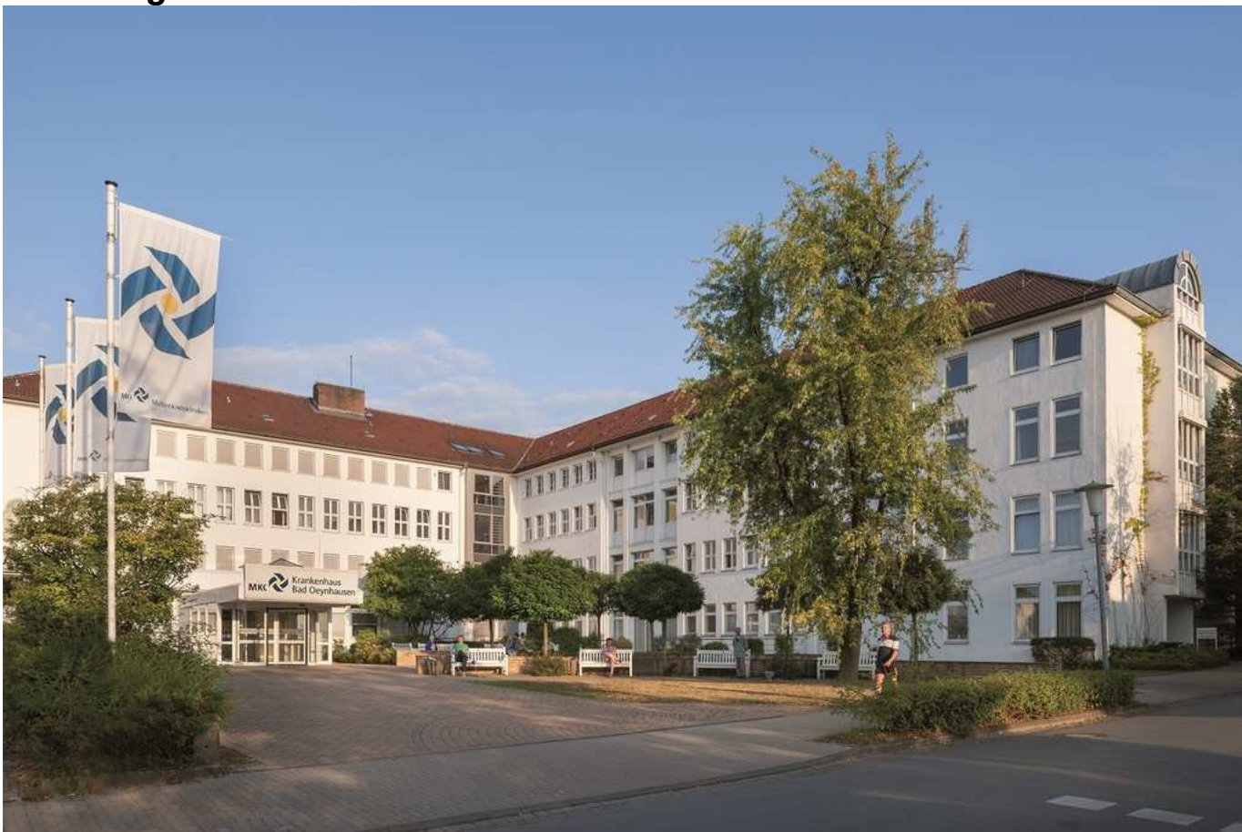
Abbildung: MKK Krankenhaus Bad Oeynhausen
